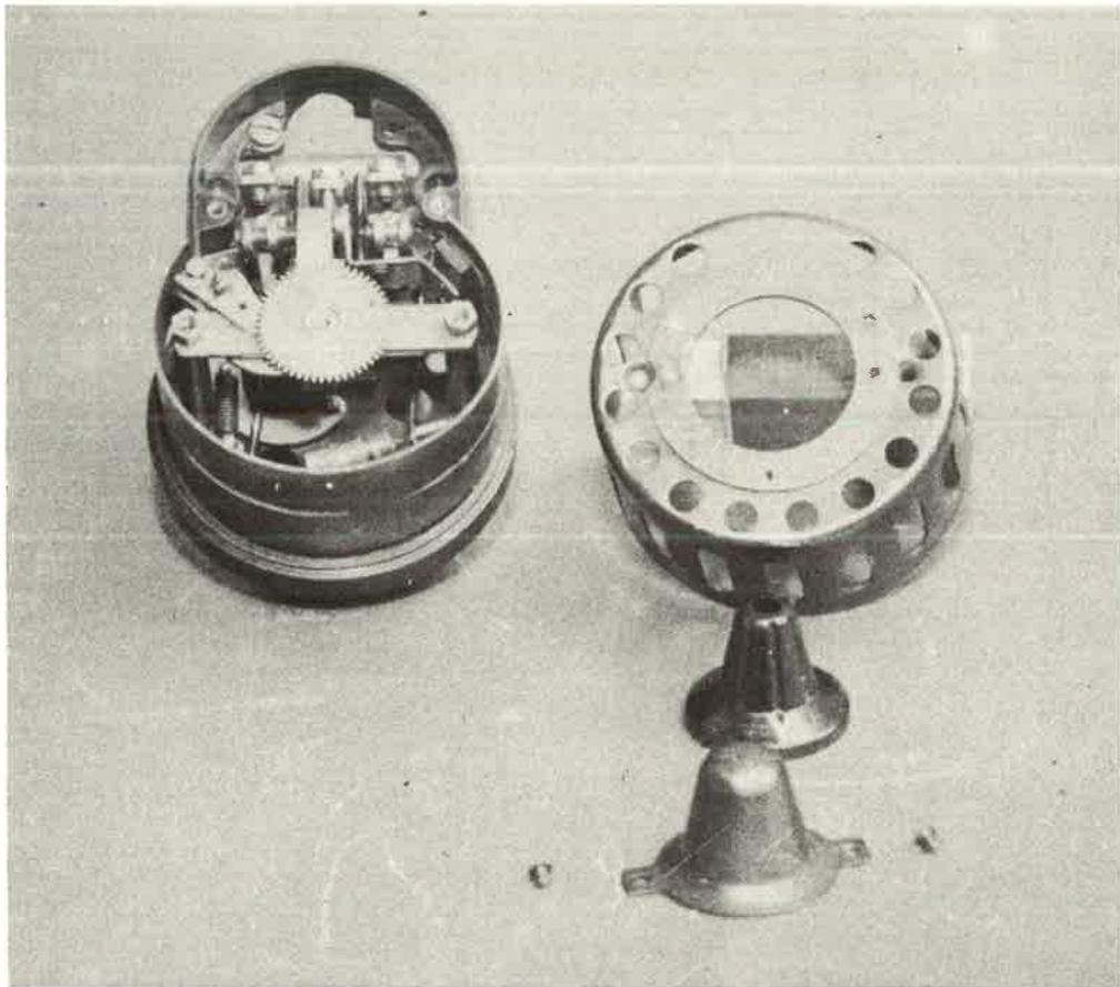
Fig. 35. — Thermostat de compartiment TC.
